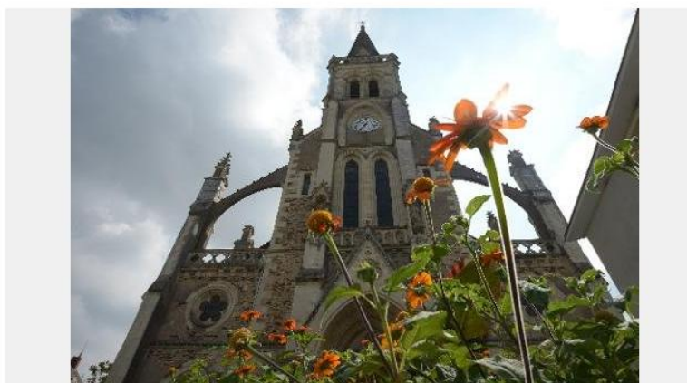
AFP/AFP - L'église de Sainte-Gemmes-d'Andigné (Maine-et-Loire) résiste à une vague de démolitions lancées par des maires - cinq déjà détruites à travers la France depuis le début de l'année
