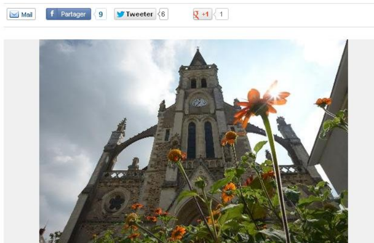
AFP/AFP - L'église de Sainte-Gemmes-d'Andigné (Maine-et-Loire) résiste à une vague de démolitions lancées par des maires - cinq déjà détruites à travers la France depuis le début de l'année
