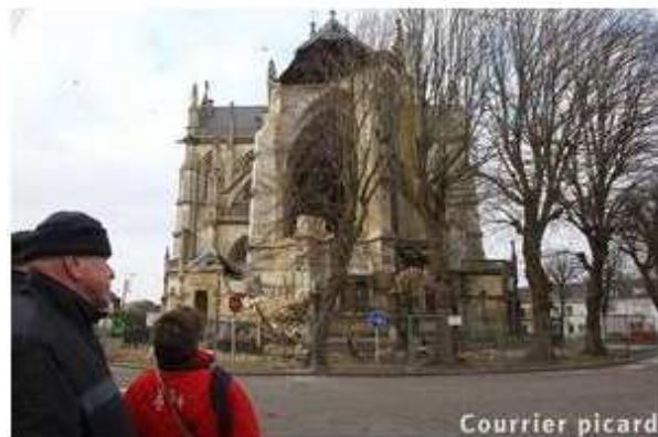
Prévue hier, la déconstruction de l'église Saint-Jacques a été reportée à aujourd'hui en raison des chutes de neige. (Photo FRED HASLIN)
