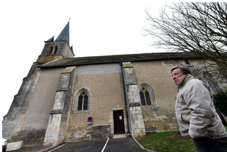
La démolition de l'édifice semble inévitable.
